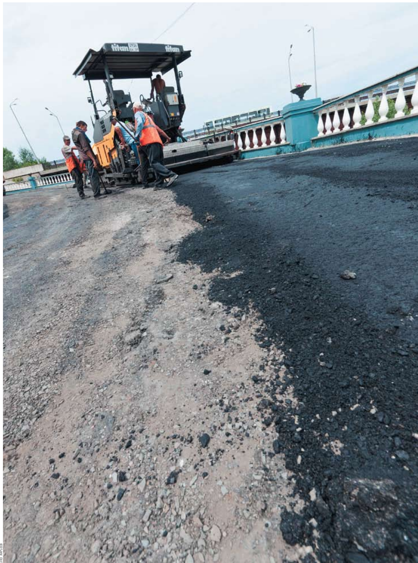
ПОТЕНЦИАЛ ИНВЕСТИРОВАНИЯ ПЕНСИОННЫХ ФОНДОВ В СТРОИТЕЛЬСТВО ДОРОГ ВЕЛИК, НО ДЛЯ ЕГО РЕАЛИЗАЦИИ НЕОБХОДИМЫ ИЗМЕНЕНИЯ В ЗАКОНОДАТЕЛЬСТВЕ
